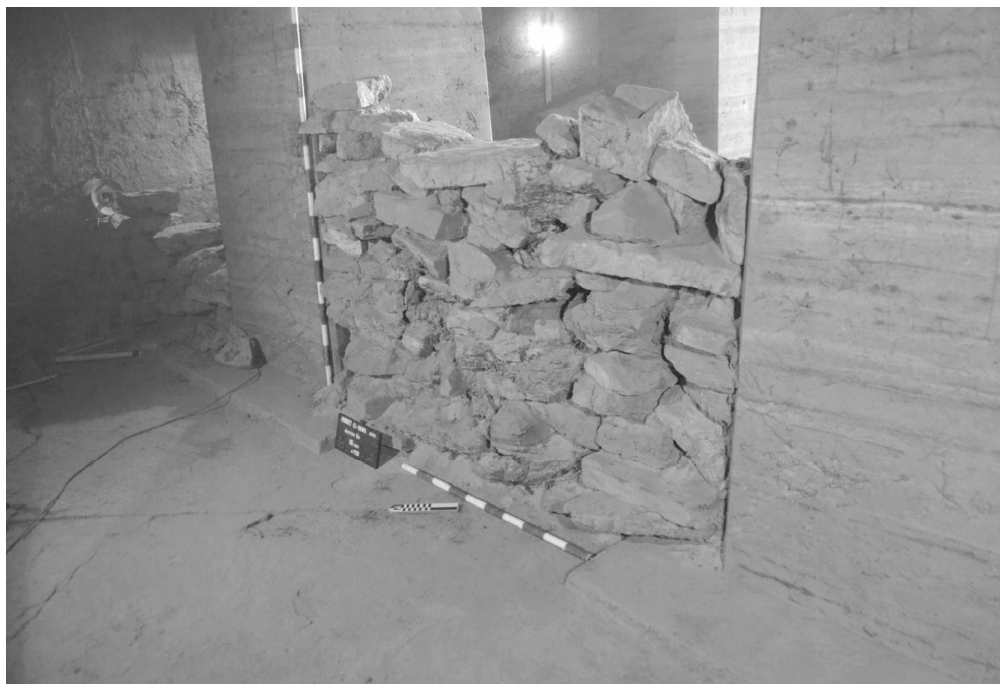
Figura 6: El muro en el C8.
