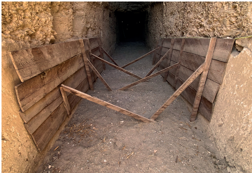
Figura 9. Imagen del corredor axial en la tumba de Djari (TT 366) antes de su limpieza, con los paneles de madera aún en posición sobre los muros sur (izqda.) y norte (dcha.) (Imagen: Middle Kingdom Theban Project)
