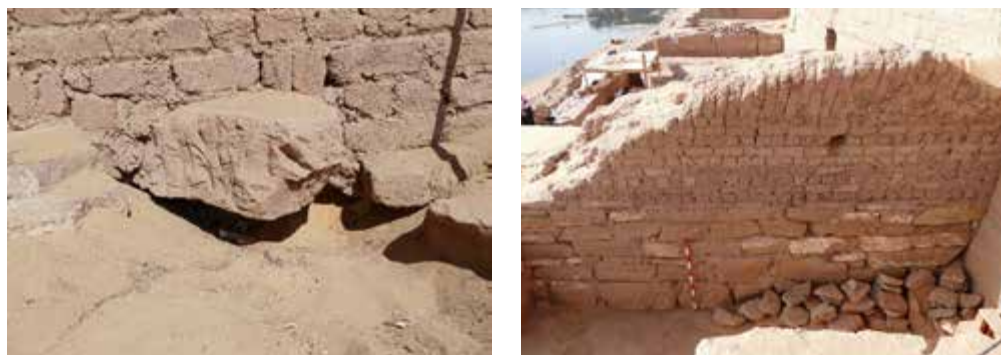
Figuras 142 y 143. Detalle de los cimientos de la cara suroeste del muro que divide QH33 y QH34. Cara noreste del muro que divide QH33 y QH34.
