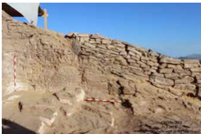
Figuras 50 y 51. La fachada de la tumba QH35n y el muro sur del patio.
