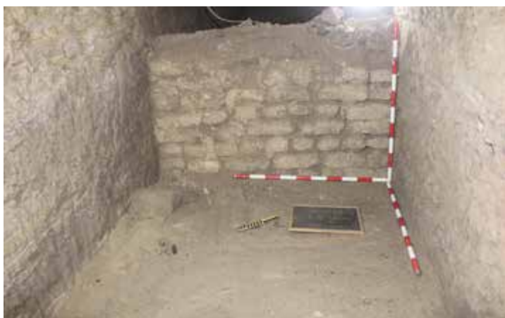
Figura 96. Cerramiento de adobe.
