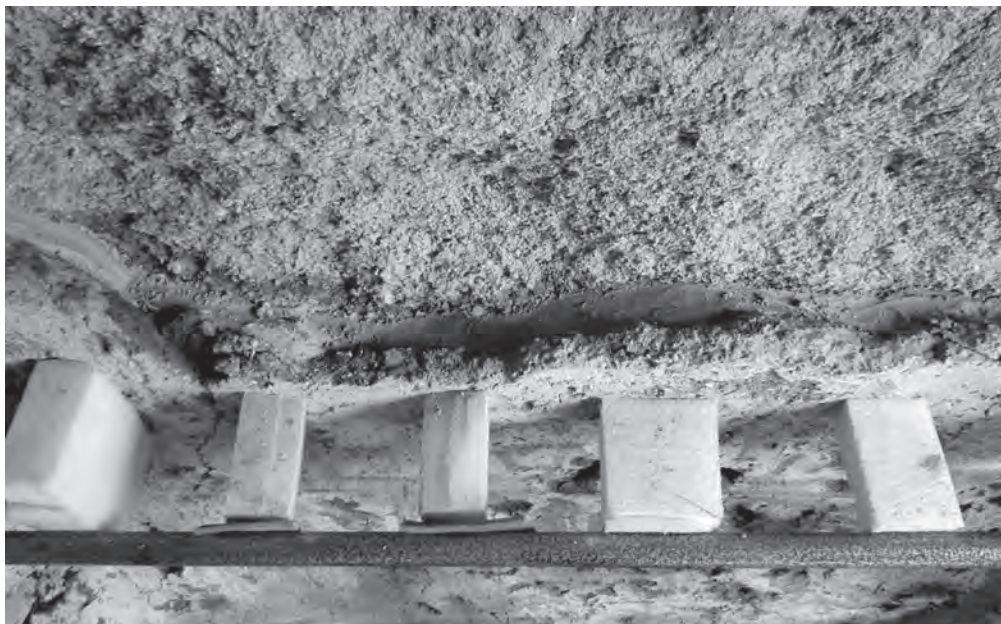
Figura 17. Relleno con mortero sintético.
