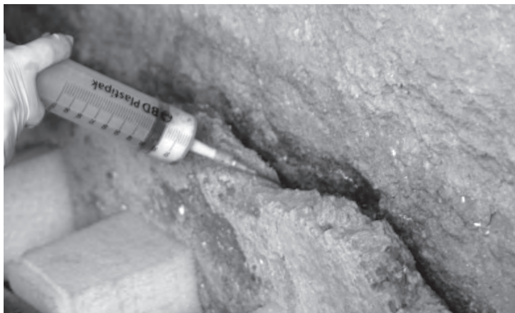
Figura 16. Inyección de consolidante.
