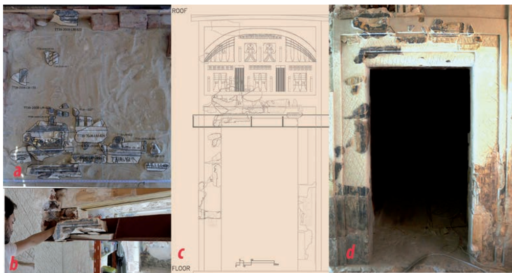
Figura 23. Proceso de análisis y restitución de portada de acceso a la Capilla Sur. Se muestra el estudio en físico para ubicación de piezas originales (a), el soporte estructural «invisible» (b), el proyecto gráfico (c) y el avance logrado durante la temporada 2018 (d). Fuente: Archivo gráfico del Proyecto Puimra TT 39. Referencia GA/MV/JT/PM/LA/RM/AO/FdL/2014-2018.
