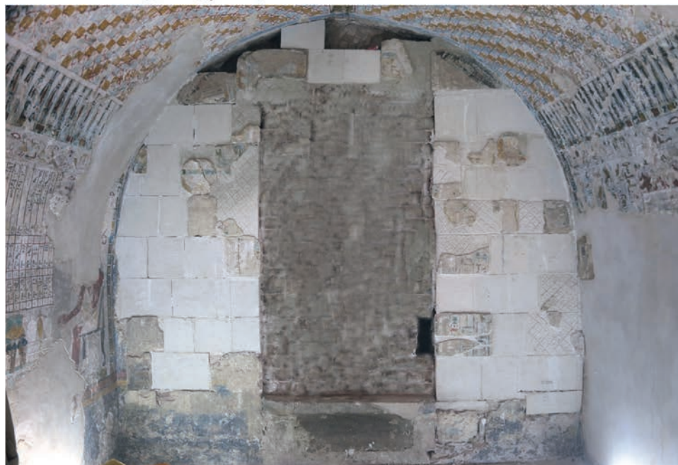
Figura 25. Croquis esquemático y fotografía del trabajo de restitución del muro oeste de la Capilla norte con fragmentos originales y sillares de caliza según evidencias de estereotomía. Fuente: Archivo gráfico del Proyecto Puimra TT 39. Referencia GA/MV/JT/RM/LA/IB/ZO/ 2013-2018.
