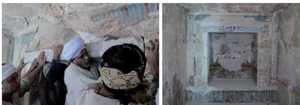
Figura 24. Proceso de restitución de dintel original del nicho de la Capilla sur. Fuente: Archivo gráfico del Proyecto Puimra TT 39. Referencia MV/2014.
