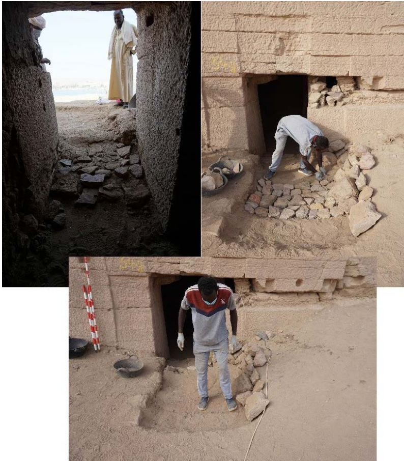
Figura 27. Acondicionamiento del interior y exterior de la entrada de la tumba QH34g.
