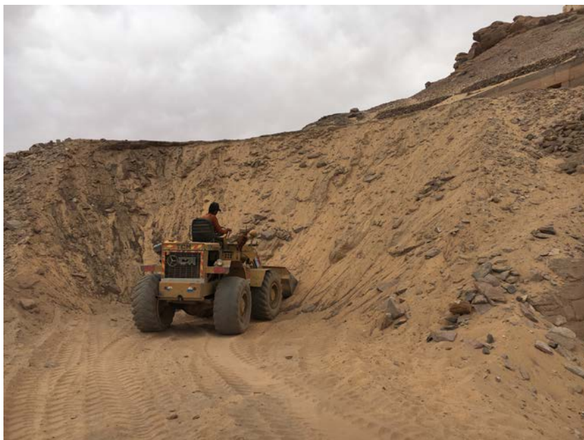
Figura 38. Excavadora durante los trabajos de retirada de la terrera.
